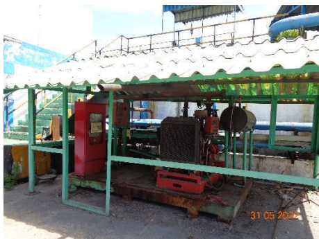
ภาพที่ 2.2-29 (ต่อ) การติดตั้งอุปกรณ์ป้องกันอัคคีภัย
